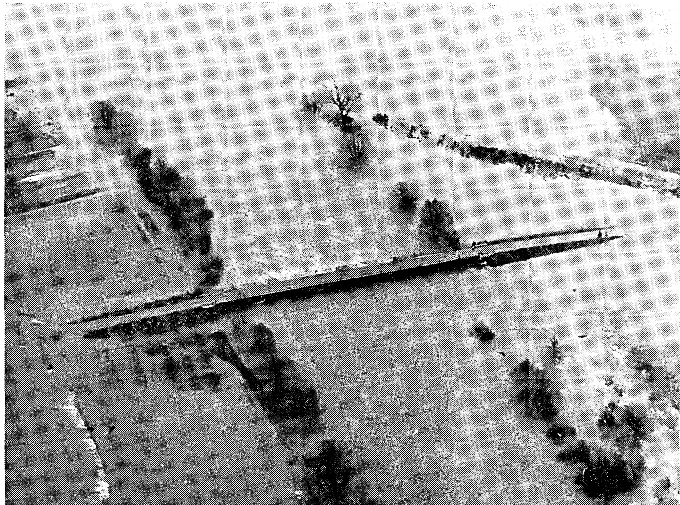
Überflutet war auch die Brücke über die Eder zwischen den Gemeinden Wega und Wellen im Kreis Waldeck. Nur der Mittelteil der Brücke ragt aus dem Wasser. Die Aufbauten sind ebenso wie die Straße auf beiden Seiten der Brücke überschwemmt. (Luftaufnahme: B, freigegeben unter Nr. 439/65 vom Regierungspräsidenten in Kassel)
